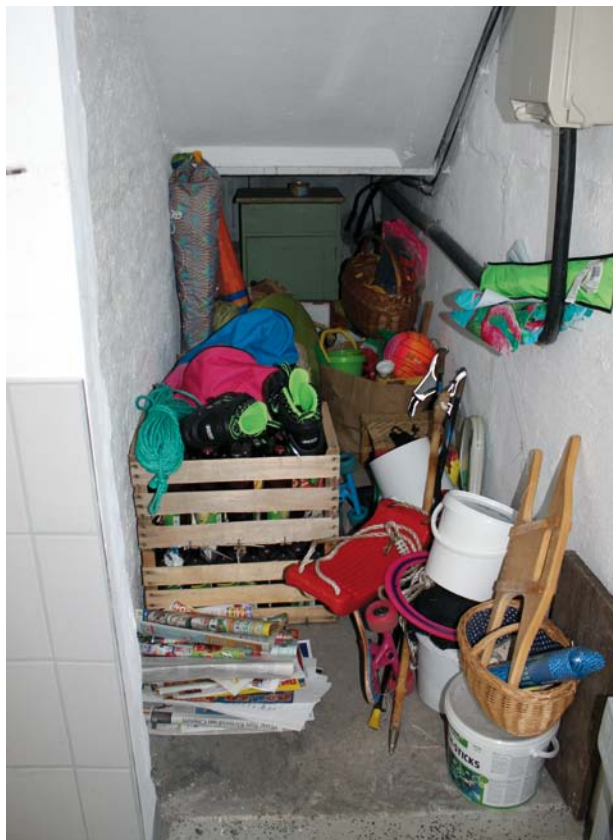
Ein Beispiel aus einem Objekt: Unerlaubte Lagerung von Sachen im Verschlag unter der Kellertreppe
