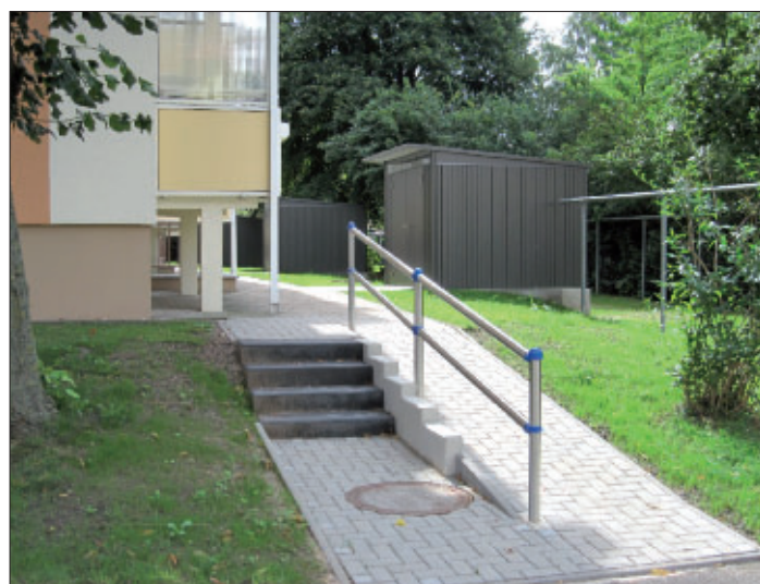
Außenanlagen/Errichtung Multifunktionshäuser Zwenkau, Am Bahnhof 1-7
