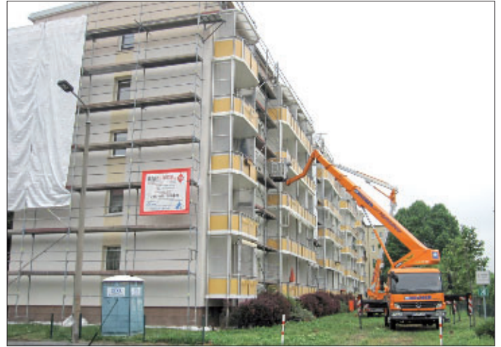
Fassadenarbeiten und Revision Balkone Leipzig, Thierbacher Straße 11-13
