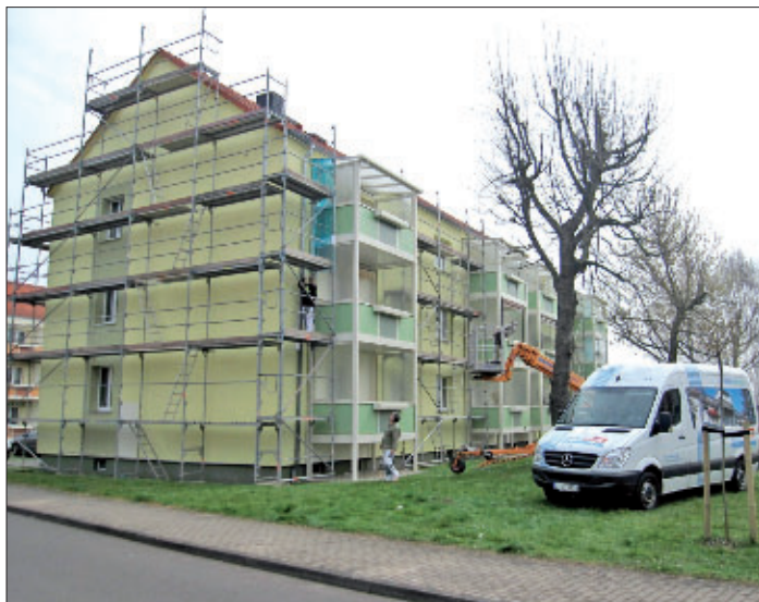
Fassadenarbeiten und Balkonrevision Groitzsch, Emil-Jahn-Straße 10 a-b
