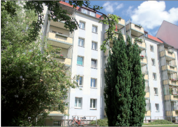
Fassadenrenovierung Leipzig, Schenkendorfstraße 48, 52-54
