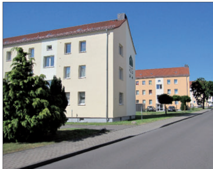
Fassadenrenovierungen Groitzsch, Emil-Jahn-Straße 8-9
