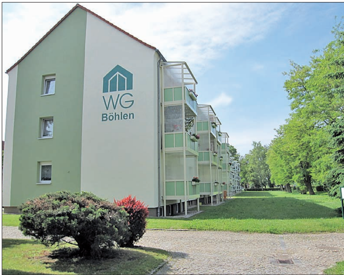
Fassadensanierung Pegau, Wachenheimer Straße 4-5
