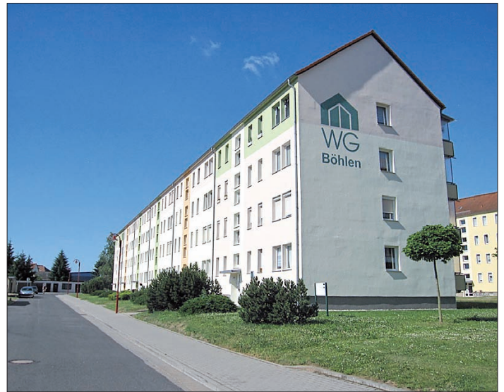
Fassadensanierung Pegau, Stöntzcher Straße 24-29
