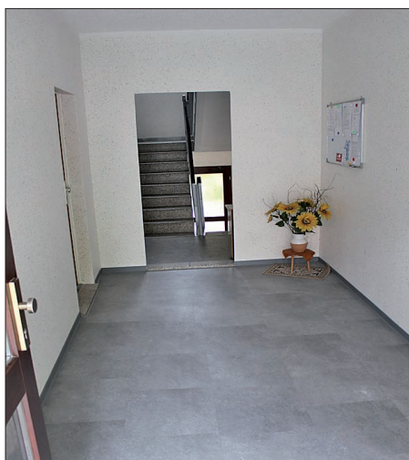
Treppenhaussanierung Böhlen, Ernst-Thälmann-Straße 18-24
