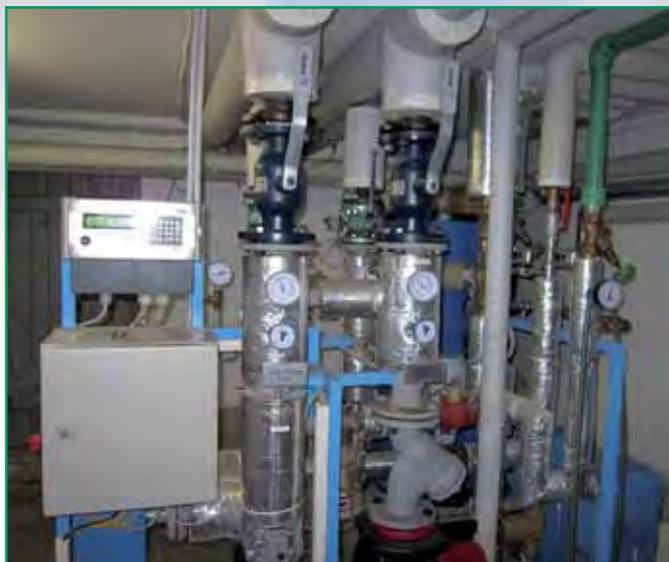
Neue Heizungstechnik im Keller (hier eine Fernwärmestation)
