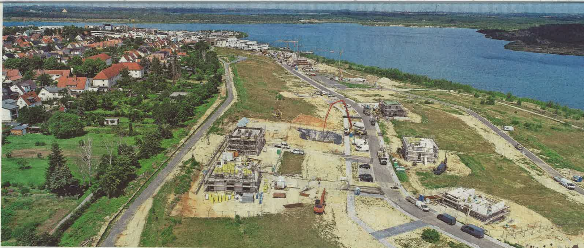
Das im Bau befindliche Wohngebiet Harthweide in Zwenkau aus der Vogelperspektive: Im Sommer, als dieses Foto entstand, war der Bebauungsplan gerade für unwirksam erklärt worden. FOTO: ANDRÉ KEMPNER
